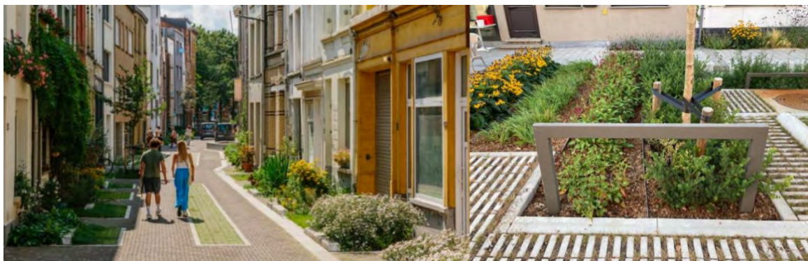
Figuur 34: Vlnr: (1) Ontharding met boven- en ondergrondse infiltratie in centrum Antwerpen. © Aquafin; (2) Infiltrerende plantvakken in Aziëlaan (tuinstraat Wilrijk). © Aquafin
