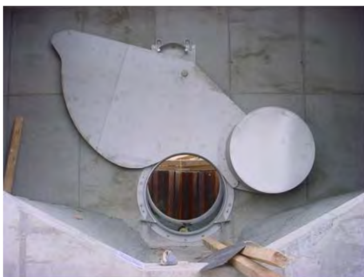
Figuur 45: Links: Debietregelaar. Bron: Morselt.com. Rechts: Regelbare afsluiter. Bron: KWT.be.
