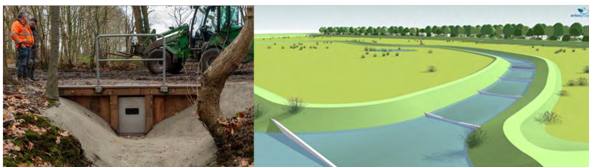
Figuur 68. Links) Regelbare knijpstuw Ulvenhouts bos (Nederland). Bron: Naturetoday.com. Rechts) Vispasseerbare drempels in waterloop afwaarts van natuurgebied. Zo wordt opstuwing gecreëerd zonder dat een vismigratieknelpunt ontstaat. Dit principe werd toegepast bij de herinrichting van 'de Hellekens' in Herentals. Bron: VMM.
