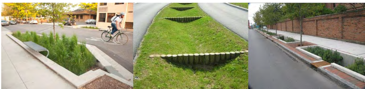
Figuur 42. Voorbeelden van lokale buffers/infiltratievoorzieningen. Zo kunnen reeds bestaande verkeerselementen ook een waterfunctie vervullen en voorzien in infiltratie en buffering op straatniveau (Bron links: Clay street door Green Works).
