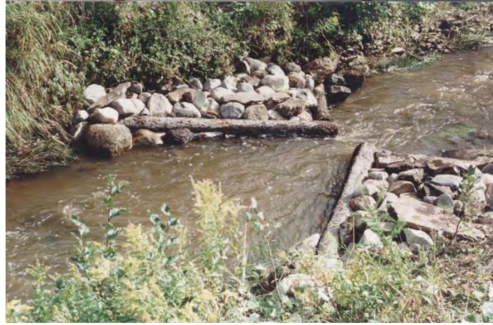
Figuur 65: Stroomdeflector met stenen en hout. Bron: www.afterwildfire.org .
