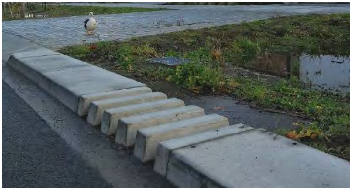
Figuur 38. Een voorbeeld van een boordsteen met spleten zoals toegepast in de Fortstraat in Morsel (Bron: dbpubliekeruimte.info).
