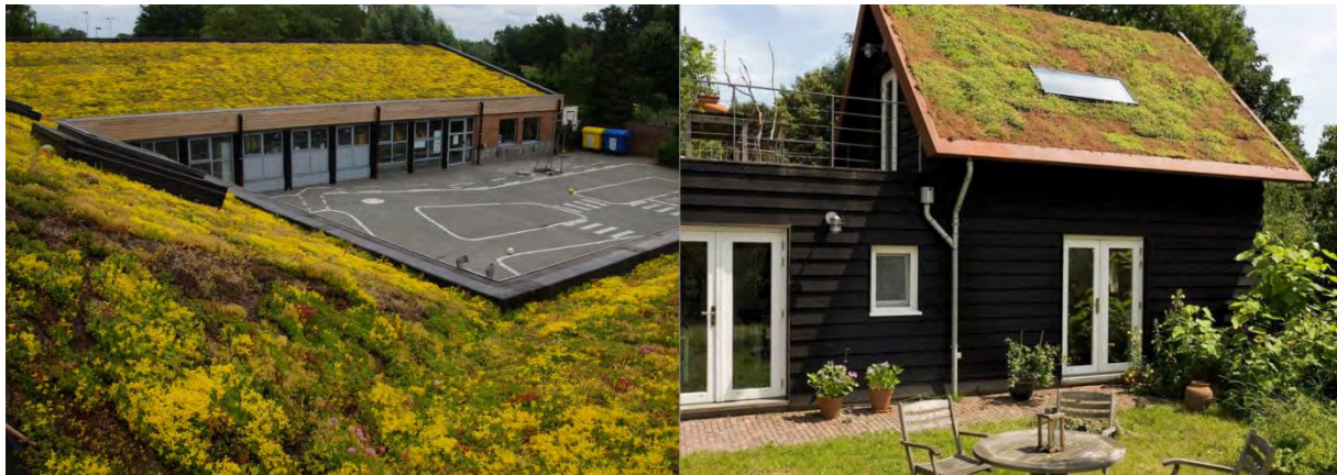
Figuur 48. Voorbeelden van een groendak. Links wordt een groendak toegepast op een groot, weinig hellend dak van de basisschool in Meerdonk Sint-Gillis-Waas. Rechts is het toegepast op het dak van een privé woning. Bron: Blauwgroen Vlaanderen.
