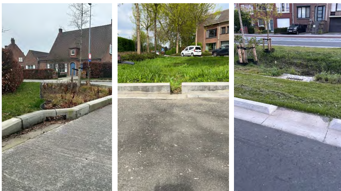
Figuur 32: voorbeelden van insnijdingen in een boordsteen om hemelwater in een plantbed te laten lopen
