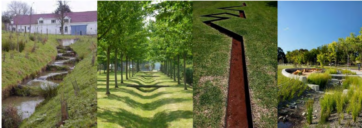
Figuur 43. Blauwgroene afvoerwegen bieden een breed spectrum aan inrichtingsmogelijkheden. Van links naar rechts: een gracht met kunstmatige meandering om te vertragen, een laanvormige infiltratiekanaal, een zeer strak vormgegeven meandering en een waterspeeltuin waar afhankelijk van de waterstand delen rond de speeltuin zich vullen of de speeltuin mee overstroomt.
