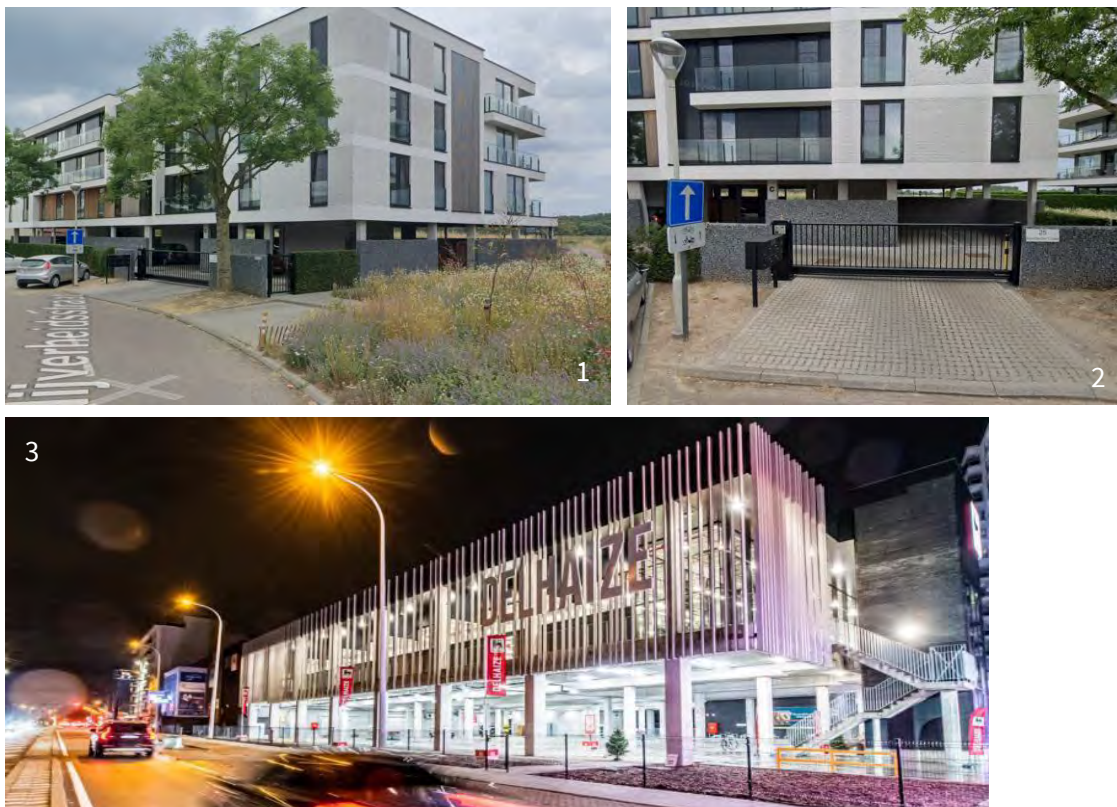
Figuur 49: Voorbeelden van gebouwen op palen waarbij de gelijkvloerse verdieping gebruikt wordt voor parking en toegang. (1 en 2) Nieuwbouw appartementsgebouw in de Nijverheidskaai in Rumst, op de oever van de Rupel; (3) Nieuwbouw supermarkt Delhaize in Mechelen
